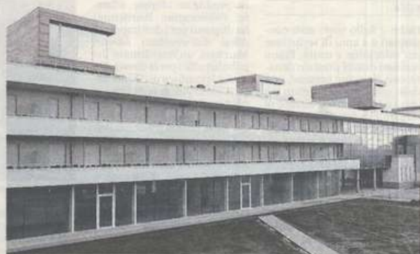
Un particolare dell'edificio centrale con le "lanterne" in alto
