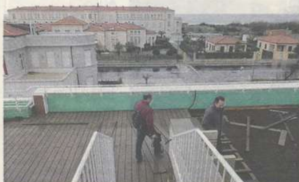
Dalla "lanterna" si accede al giardino pensile qui in fase di costruzione
